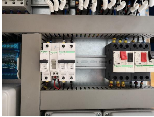
Rys. 1. Zabezpieczenie obwodów sterowania i obwodów obciążenia
