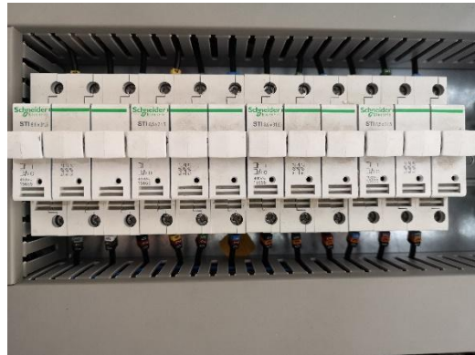
Rys. 2. Zabezpieczenie stopni kompensacyjnych
