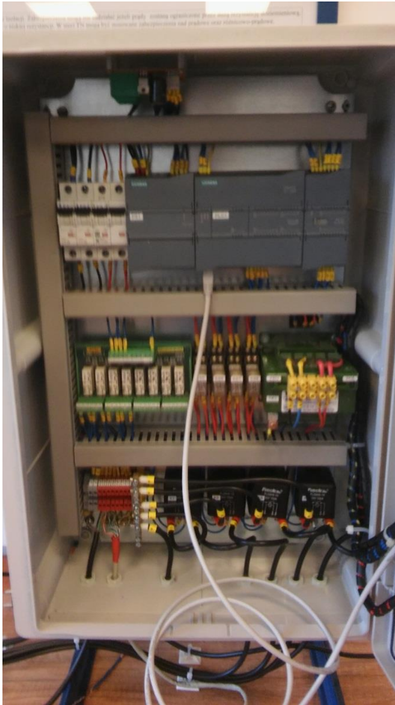
Rys.2. Wnętrze skrzyni sterowniczej
